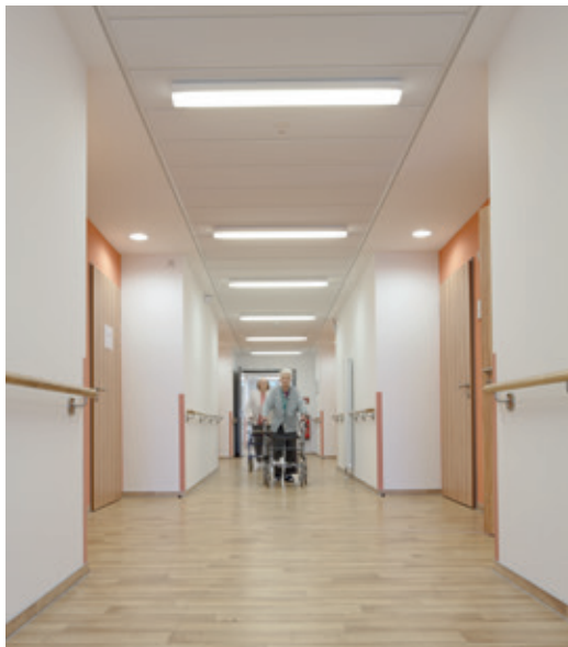
Abbildung 4.51: Flurbeleuchtung: links Beleuchtung ohne Blendung, rechts: Reflexionen des Tageslichtes am hochglänzenden Bodenbelag und an den Wänden führt zu Blendung
