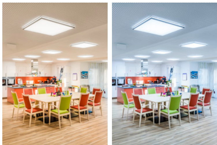
Abbildung 4.55: Lichtdecke in einem Altenheim
