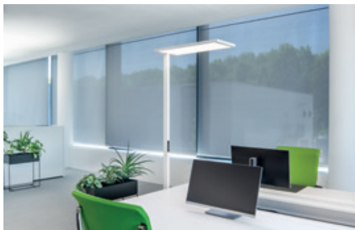
(c) Arbeitsbereichsbezogene Beleuchtung mit Standleuchten
