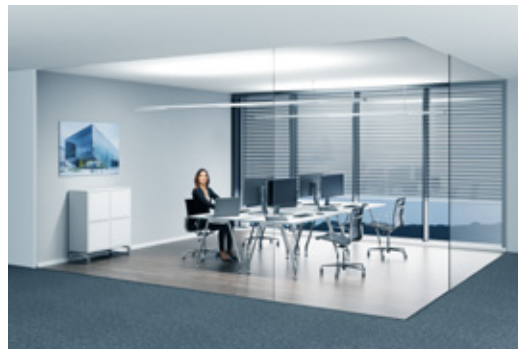
(d) Büroraum mit arbeitszonal angeordneten Hängeleuchten, direkt-indirekt strahlend, bei 6.000 K \bar{E}_h im Arbeitsbereich: 1.258 lx E_v am Arbeitsplatz: 1.013 lx a_{meL,v} am Arbeitsplatz: 0,84 MEDI(32) am Arbeitsplatz: 449 \text{ lx} \cdot 0,56 \cdot 1,104 \cdot 1 = 939 \text{ lx}_{MEDI} MEDI(50) am Arbeitsplatz: 1.013 \text{ lx} \cdot 0,84 \cdot 1,104 \cdot 0,66 = 620 \text{ lx}_{MEDI}
